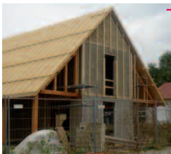
Associé à la chaux, le chanvre forme un béton naturel à isolation répartie, parfaitement adapté à l'ossature bois.
