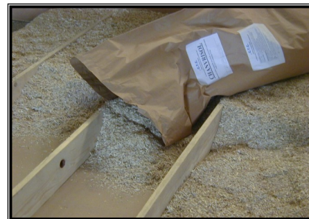
Application en comble perdu
