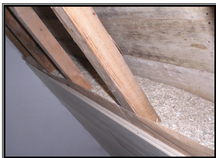
Application en rampant
